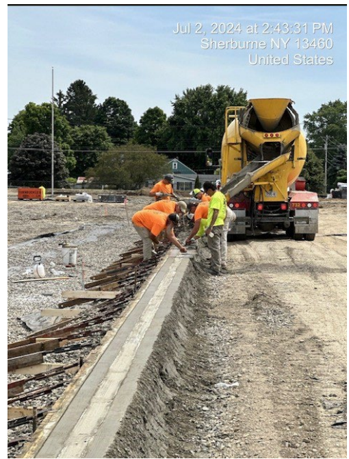
Slot Drain Concrete Collar Pour
